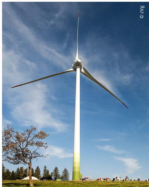
Klimafreundlich: der Wind, der gratis Energie liefert
